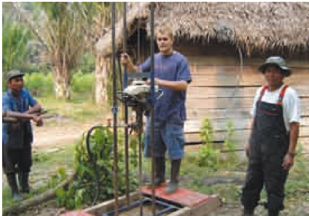
Wasserbohrung in Bolivien: Auch der Freiwillige darf sich am Bohrgerät versuchen.
